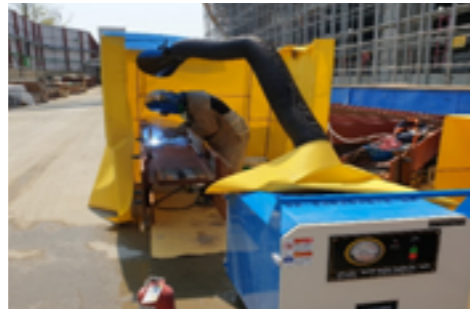
간이 칸막이 및 이동식 집진 시설 설치 현장
